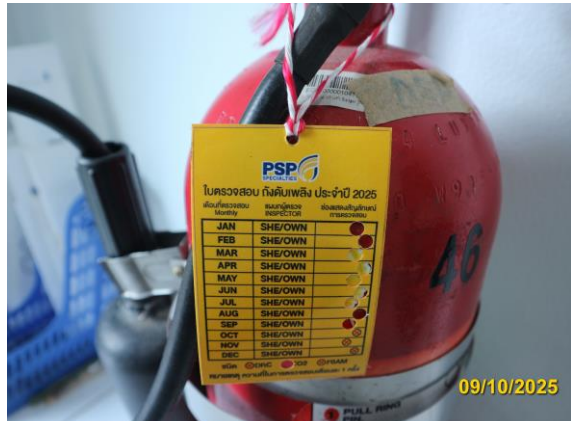
รูปที่ 3-27 ตรวจสอบอุปกรณ์ป้องกันอัคคีภัย
