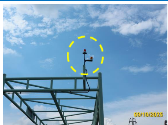
รูปที่ 3-20 ไฟสัญญาณแสดงตำแหน่งท่าเทียบเรือ
